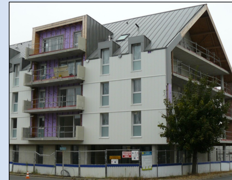
Habitat collectif avec premier niveau au dessus des plus hautes eaux connues- Quartier de Vilvent -Nazelles-Négron
