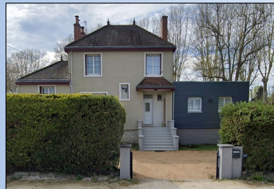
Construction avec extension
